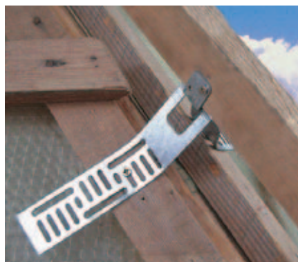
Крепление коньковой рейки универсальным держателем
