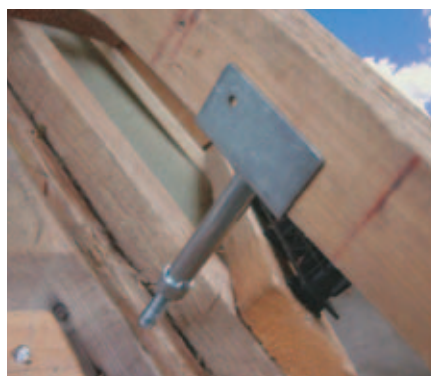
Крепление коньковой рейки держателем с гвоздем
