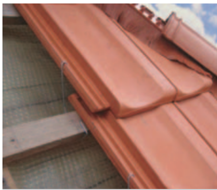
Крепление прессованной черепицы специальным крепежным элементом
