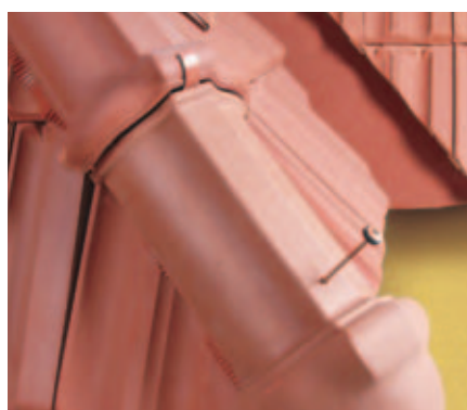
Крепление коньковой (хребтовой) черепицы специальным крепежным эле- ментом
