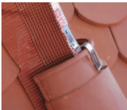
Крепление ленточной коньковой черепицы специальным зажимом
