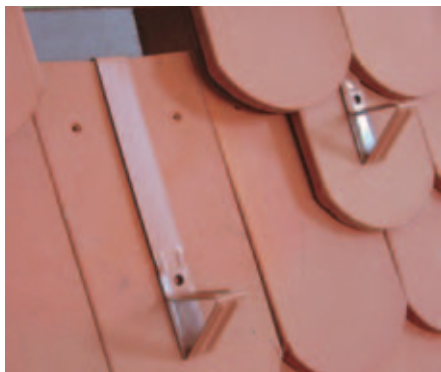
Крепление снегозащитных крюков
