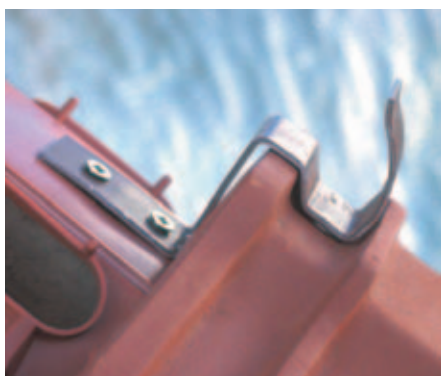
Крепление прессованной коньковой черепицы специальным зажимом
