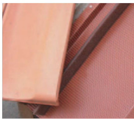
Применение уплотняющей самоклеющейся ленты для ендовы
