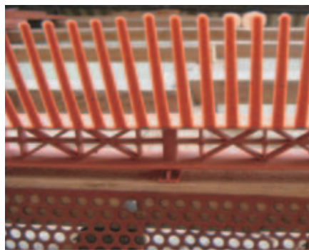
Применение защитной сетки у карнизного свеса
