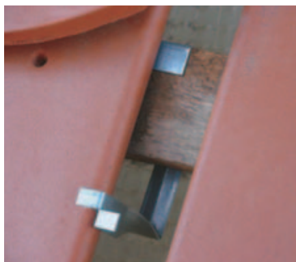
Боковое крепление ленточной черепицы специальным крепежным элементом
