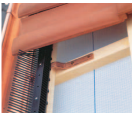
Применение аэроэлемента свеса
