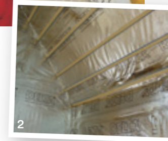
1, 2. Монтаж фольгированной пароизоляционной плёнки
