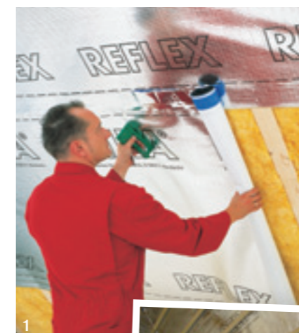
1, 2. Монтаж фольгированной пароизоляционной плёнки
