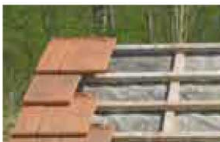
Rive débordante en Giverny PV: Le couvreur utilisera les accessoires adaptés: 89GPV: Rive Normande Gauche Giverny PV et 895GPV: Rive et demie Normande Gauche Giverny PV
