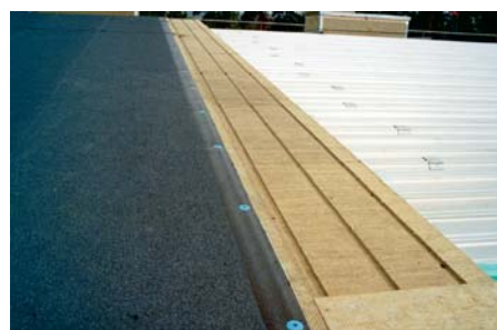
Рисунок 1: Сечение плоской кровли с применением пазовой теплоизоляции.
