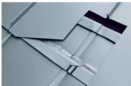
Оптимизация узла: дополнительная планка
