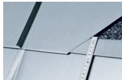
Поперечный шов, как простой фальц
