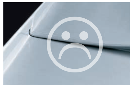
Конек односкатной кровли без деформационной зоны, небольшой торцевой фальц
