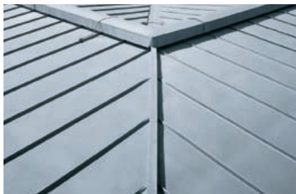
Гребень с брусом и профилем покрытия
