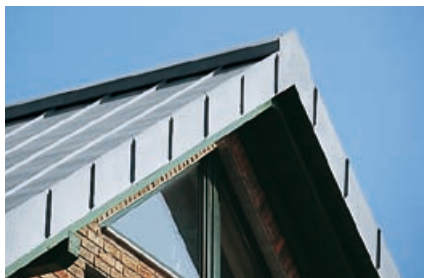
Вентилируемый конек двускатной крыши, высокое исполнение
