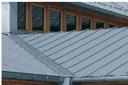
Ендова с простым и дополнительным фальцем
