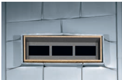
Проем в крыше Правильное исполнение в фальцевой технике (см.стр.12)
