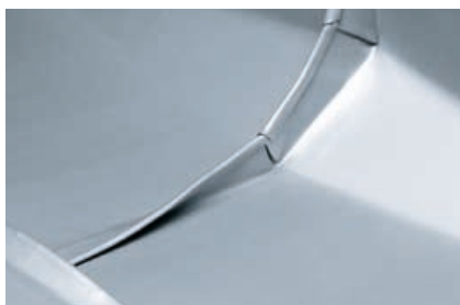
Двойной фальц конвертом в поперечном направлении (3) Тыловая часть
