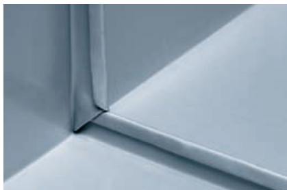
Фальц конвертом у проема кровли (2) фронтальная часть
