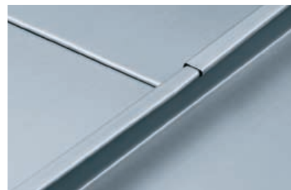
Фальц в фальц – поперечный шов для углового стоячего фальца
