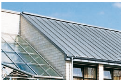
Конек односкатной кровли с бруском кровли
