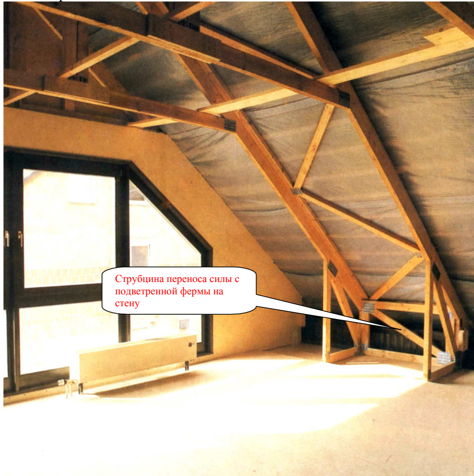
Струбцина, переносящая силу с подветренной фермы на стену
