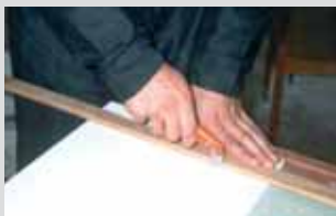
Надрез гипсоволокнистого листа по линии разметки ножом для ГВЛ
