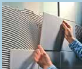
Облицовка плиткой с помощью клея КНАУФ-Флизен
