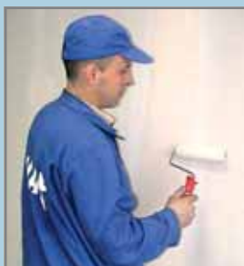
Нанесение краски с помощью валика
