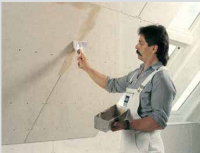
Рис.11. Шпаклевание стыков КНАУФ-суперлистов
