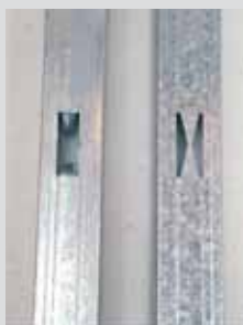
Устройство отверстий в стойках
