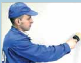
Грунтование с применением КНАУФ-Тифергрунд производится кистью
