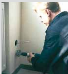
Прорезание отверстий при помощи электродрели с фрезой
