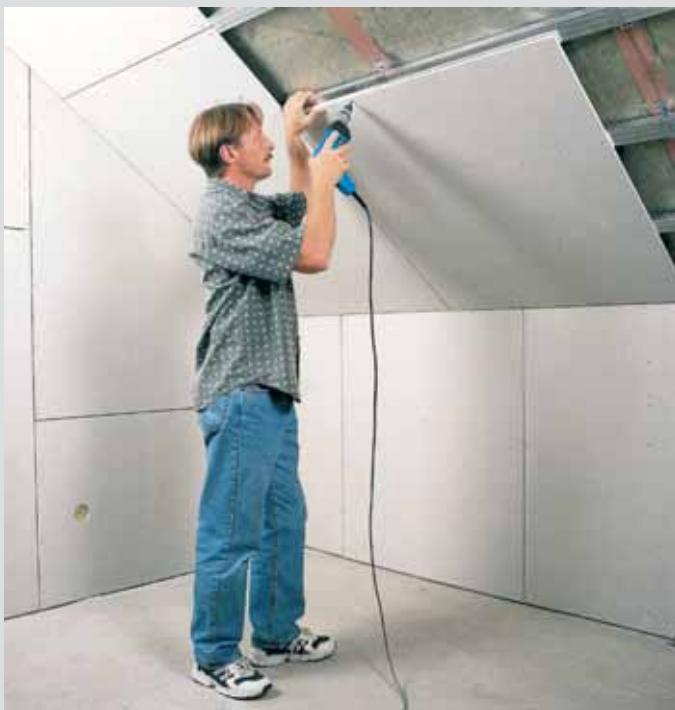
Рис.16 Крепление КНАУФ-суперлистов на каркасе
