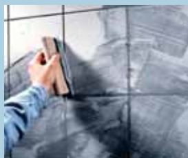
Затирка швов с помощью КНАУФ-Фугенбунт
