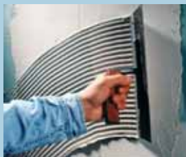
Нанесение клея
