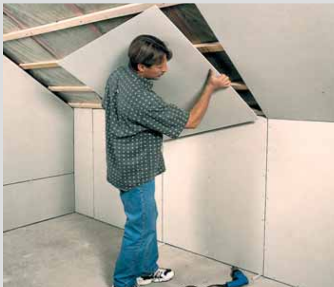
Рис. 6. Монтаж КНАУФ-суперлистов
