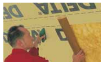
Пароизоляционная плёнка с ограниченной диффузией пара.
