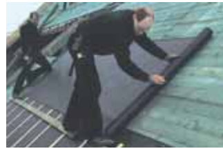
Крыши со сплошным настилом и двухслойной вентиляцией.
