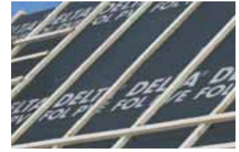
Чердачные или мансардные крыши с двухслойной вентиляцией.
