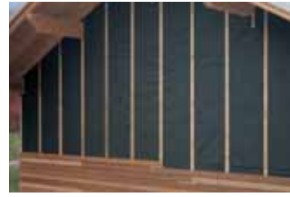
Ветрозащитная и гидроизоляционная плёнка для фасадов с открытыми швами в облицовке.
