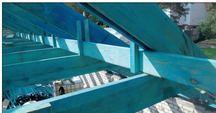
8) Konzolová vaznice ze dvou řošen 20 x 150 mm
