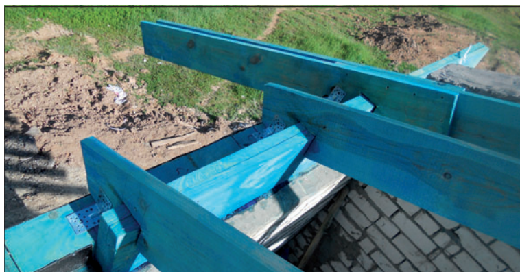
7) Štítová vaznice ze dvou řošen 40 x 250 mm
