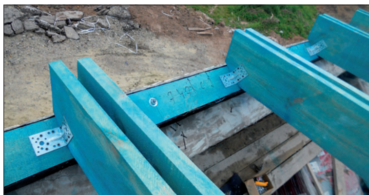
11) Opěrný bod krokve na pozednici
