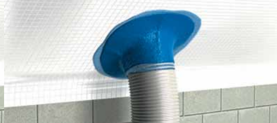
Наносится завершающий слой пасты – примыкание готово!
