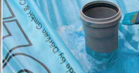
Уплотнение кровельной проходки при реконструкции.
