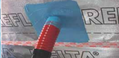
Герметизация вентканала при новом строительстве.
